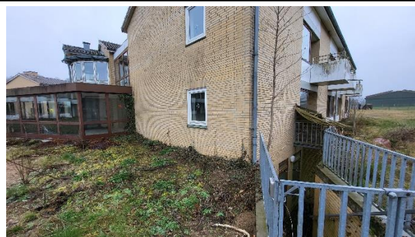
Gebäude, z.T. unterkellert
