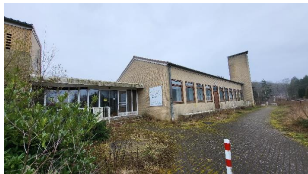
Abzureißendes Gebäude mit ehemaligem Haupteingang
