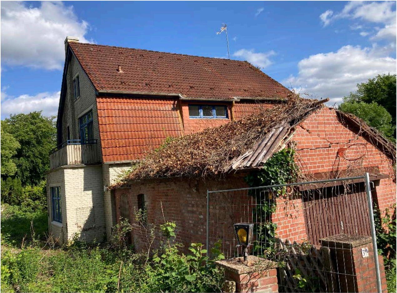
Abb. 2: Foto von dem abzureißenden Gebäude (Rövkampallee 30).
