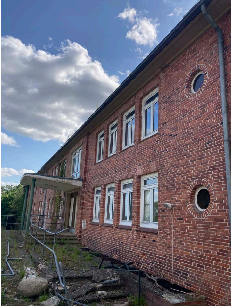
Abb. 3: Foto von dem abzureißenden Gebäude (Rövkampallee 28).
