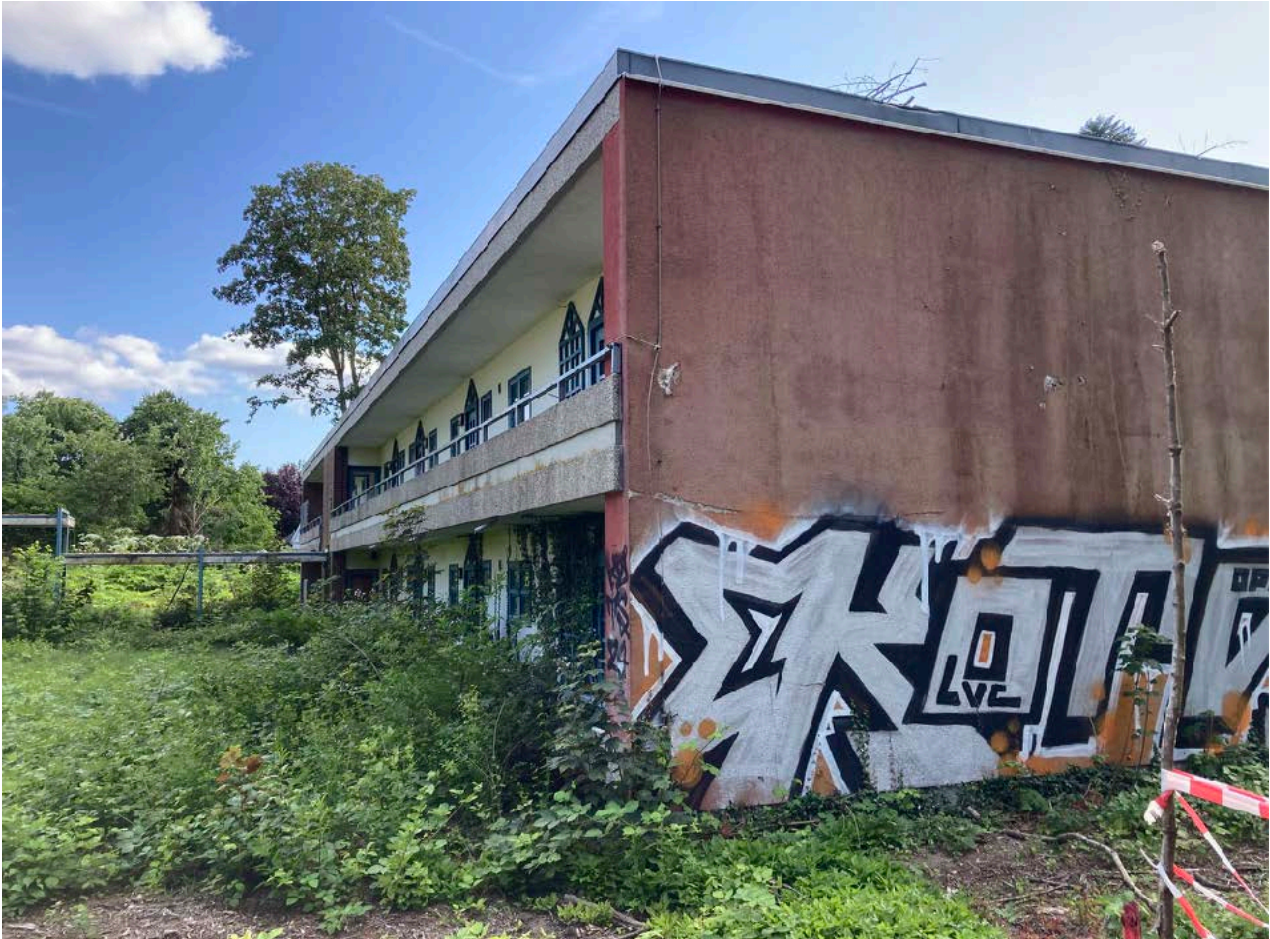
Abb. 5: Foto von dem abzureißenden Gebäude (Rövkampallee 24).
