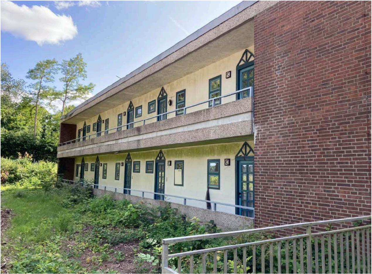
Abb. 4: Foto von dem abzureißenden Gebäude (Rövkampallee 26).
