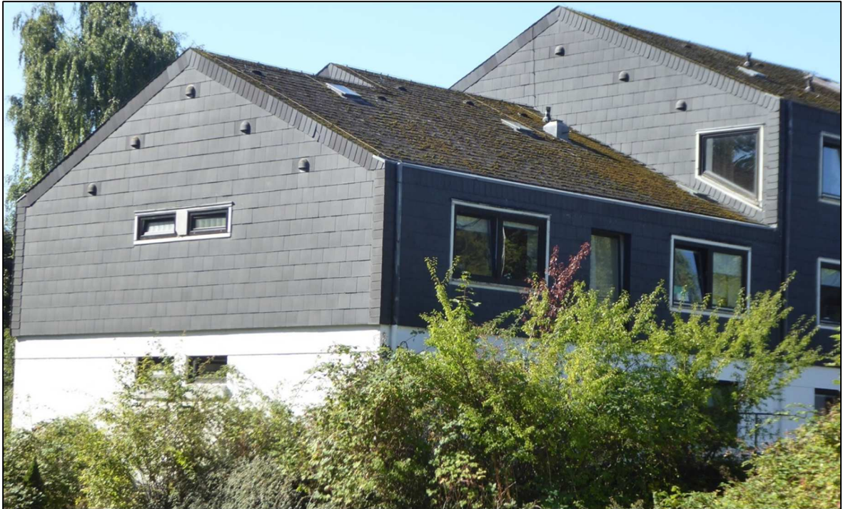
Abbildung 4: Beispiel eines Wohnhauses (20.09.2022)
