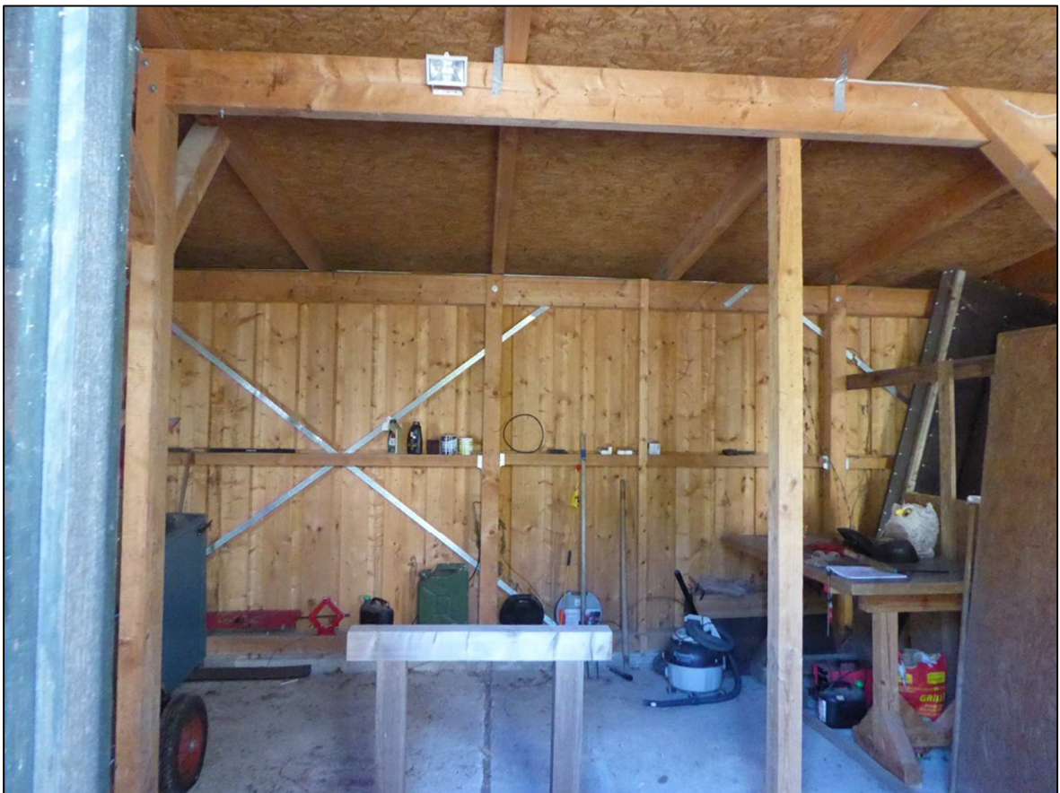
Abbildung 7: Ansicht der Remise C (20.09.2022)
