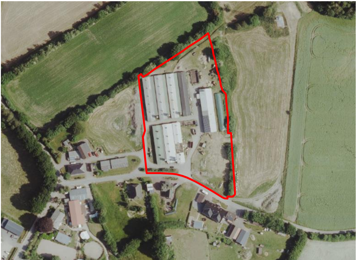
Abb.: Ausschnitt Luftbild, Digitaler Atlas Nord mit Geltungsbereich des Bebauungsplanes (alle baulichen Anlagen im Geltungsbereich wurden inzwischen zurückgebaut und mit der Erschließung als Wohngebiet begonnen)
